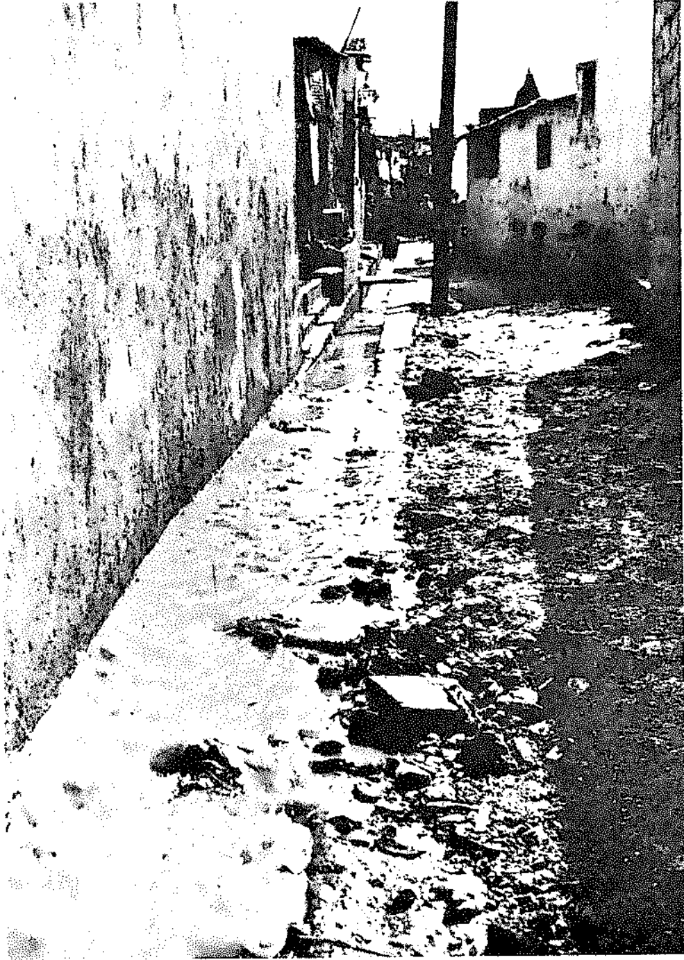
القاذورات والمياه الطافحة من المجاري المكشوفة الملاصقة لجدران المساكن في فصل الشتاء
